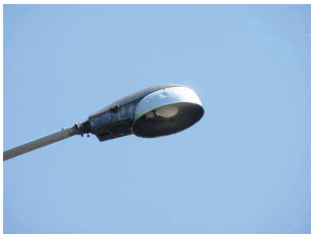
Apparecchi di tipo stradale aperto, con sorgente luminosa ai vapori di mercurio HG AP, NON CONFORMI;
