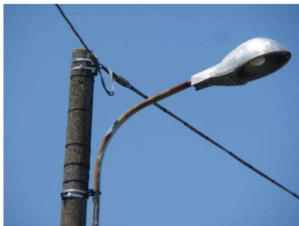
Apparecchi di tipo stradale aperto, con sorgente luminosa ai vapori di mercurio HG AP, NON CONFORMI;
