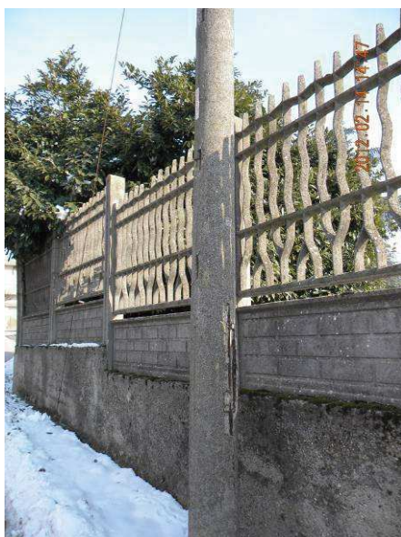
Via G. verdi - Palo in cemento, sbrecciato, da sostituire;
