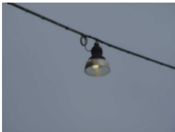
Apparecchi stradali di tipo aperto sospeso con sorgente luminosa a vapori di mercurio HG AP, NON CONFORME;
