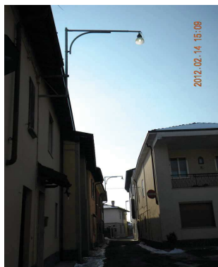
Centro luminoso con APPARECCHIO NON CONFORME;
