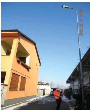
Centro luminoso con APPARECCHIO NON CONFORME;
