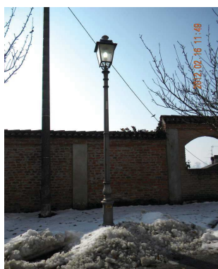
Centro luminoso con APPARECCHIO NON CONFORME;
