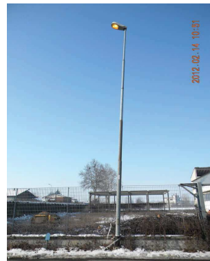
Centro luminoso con SOSTEGNO DA SOSTITUIRE;
