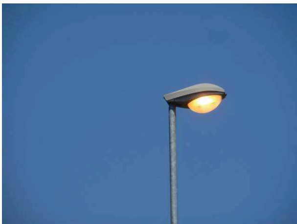
Apparecchi stradali di tipo chiuso con vetro a coppa, con sorgente luminosa a vapori di sodio ad alta pressione NA AP, NON CONFORMI;
