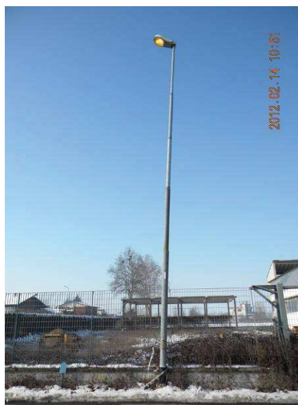
Strada Cascina Marmora - Palo in acciaio zincato da sostituire;
