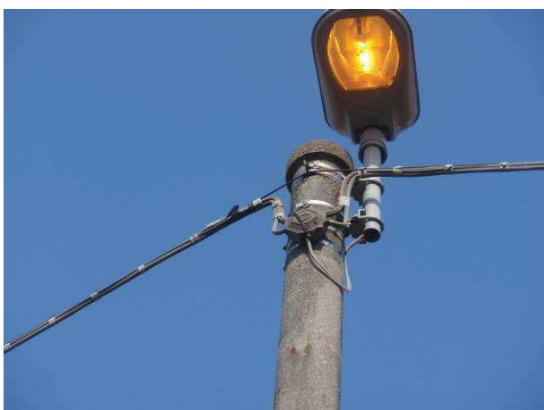
Esempi di linea aerea di proprietà Enel Sole, posati su fune in acciaio tesata a parete e/o su palificazione;
