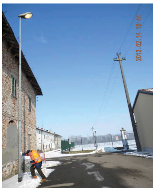
Centro luminoso con APPARECCHIO NON CONFORME;
