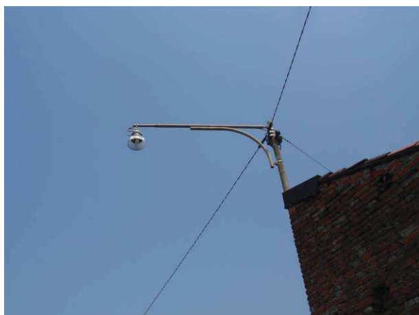
Apparecchi stradali di tipo aperto sospeso con sorgente luminosa a vapori di mercurio HG AP, NON CONFORME;
