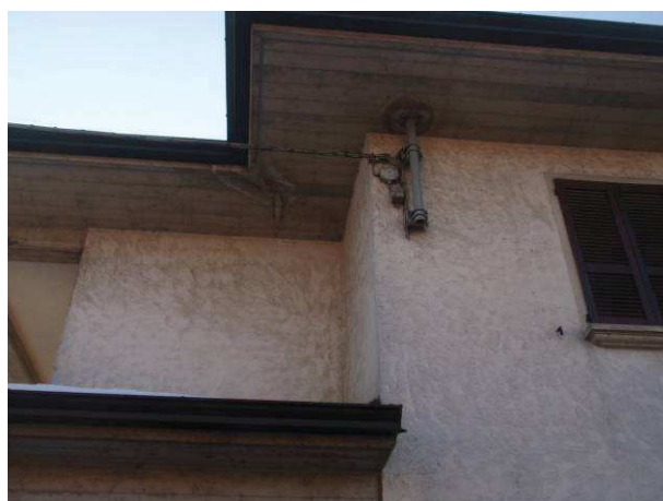
Esempi di linea aerea di proprietà Enel Sole, posati su fune in acciaio tesata a parete e/o su palificazione;
