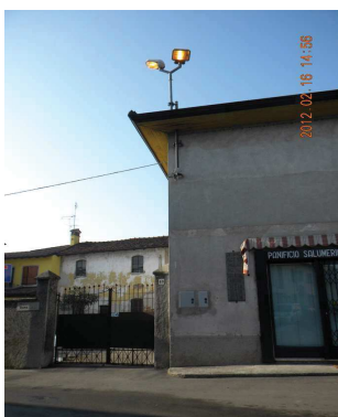
Centro luminoso con APPARECCHIO NON CONFORME e PROIETTORE CONFORME;
