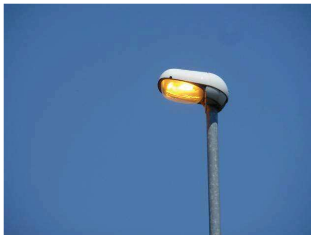
Apparecchi stradali di tipo chiuso con vetro a coppa, con sorgente luminosa a vapori di sodio ad alta pressione NA AP, NON CONFORMI;
